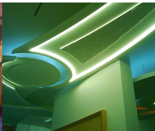
▼ Éclairage architectural : mise en relief des formes (corniches) et de l'architecture
